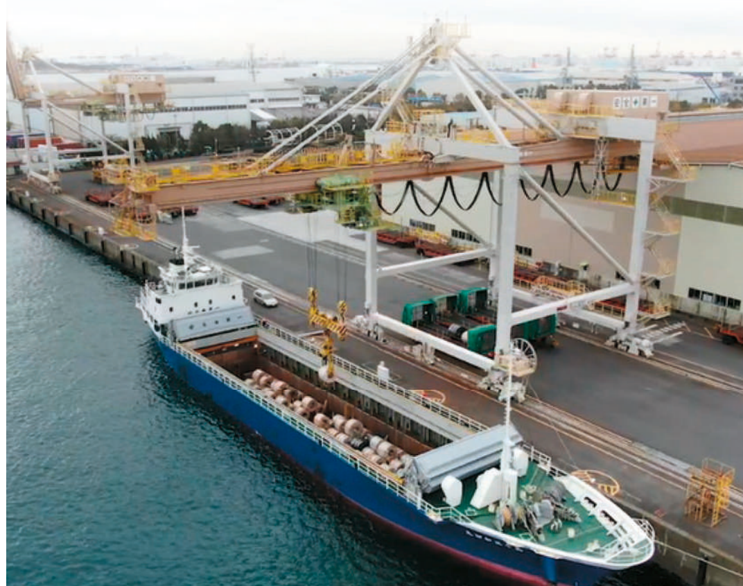
関東物流センター東京事業所
