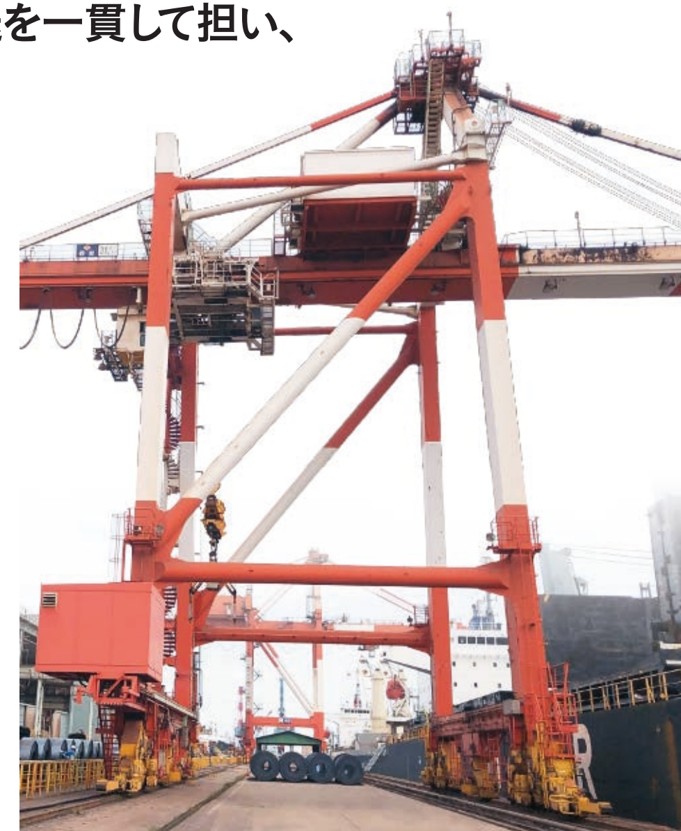
ガントリークレーン
