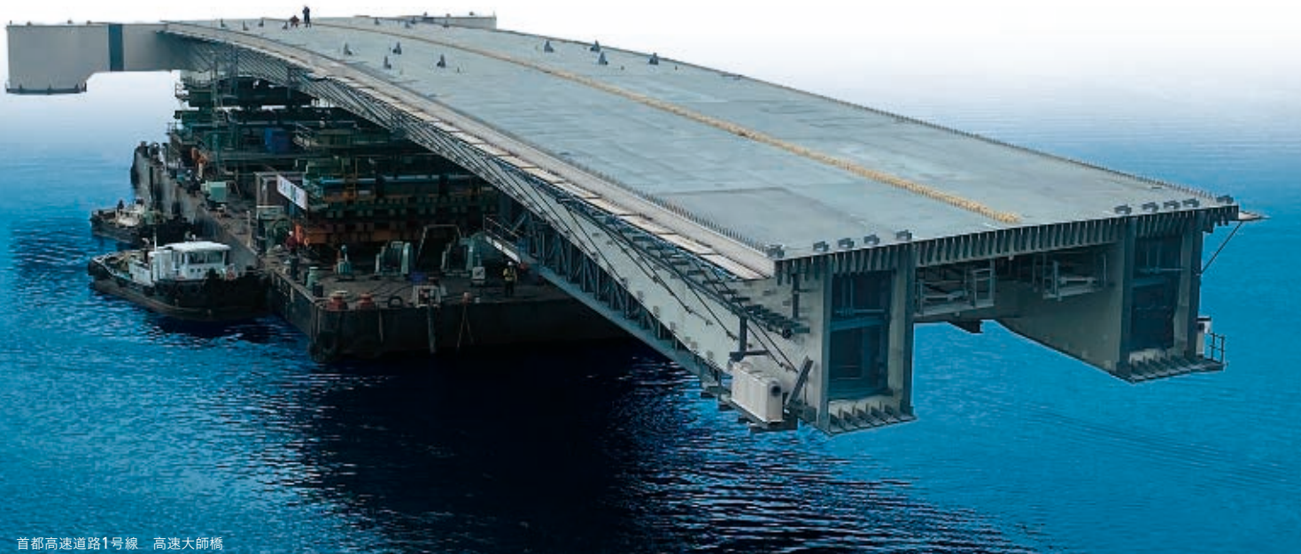
首都高速道路1号線 高速大師橋
